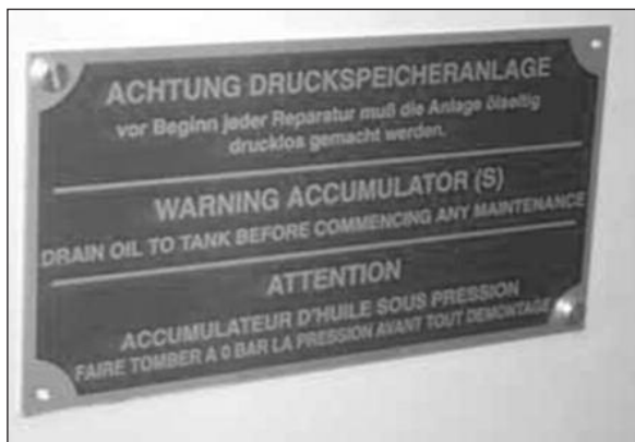
Aviso de advertencia en un sistema con acumulador.
